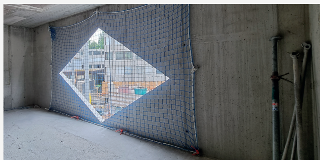
Sicherheitsnetz vertikal zum Schutz vor dem Herausfallen
