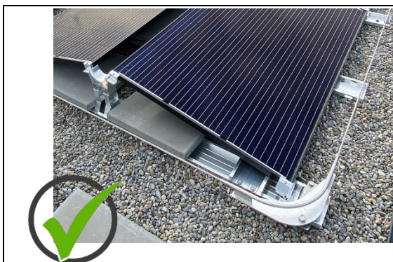
Bild 10: Korrekte Installation eines Eckelementes, da auf der belasteten Grundschiene (rechtwinklig zum First) befestigt
