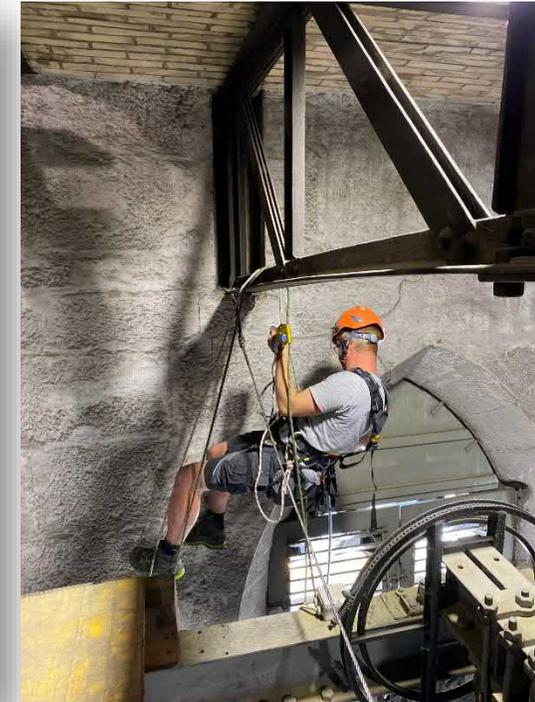
Überkopfanlage **aufgehängt** an elektrisch drehbaren «Galgen»
