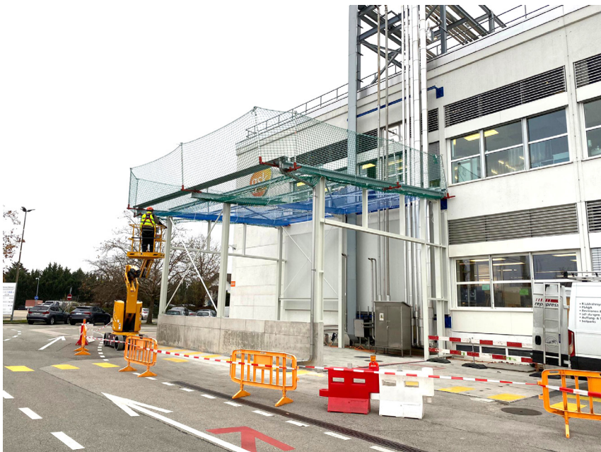
Abb. 14 Seitenschutz mit Auffangnetz ohne vorgespanntes Drahtseil
